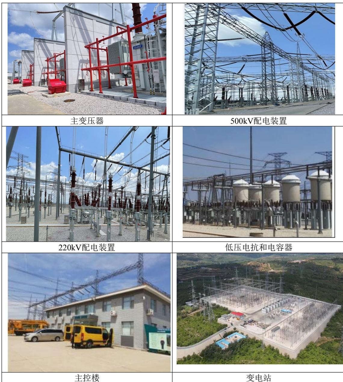
图 3.2-3 变电站内现有设备布置情况
