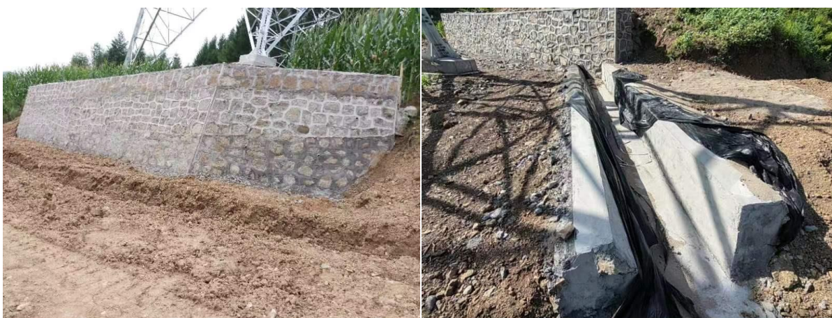
挡土墙及排水沟
