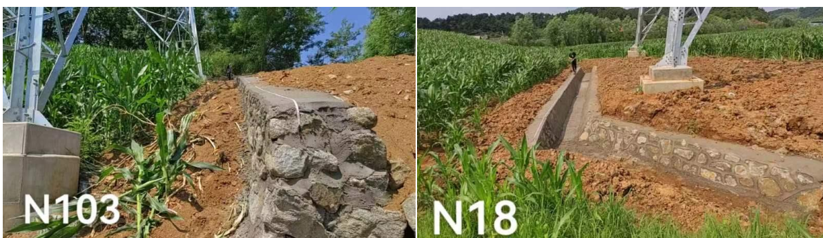
挡土墙及排水沟
