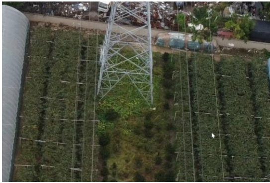
220kV 蓝熊线 13#恢复
