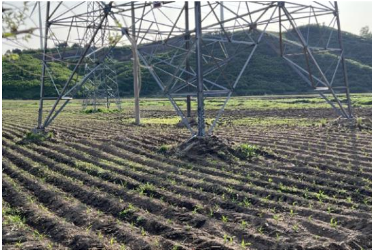
220kV 昌郭线 45#恢复
