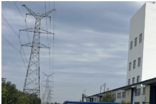
5-5) 220kV 柳树变电站至新营口牵引站线路工程
