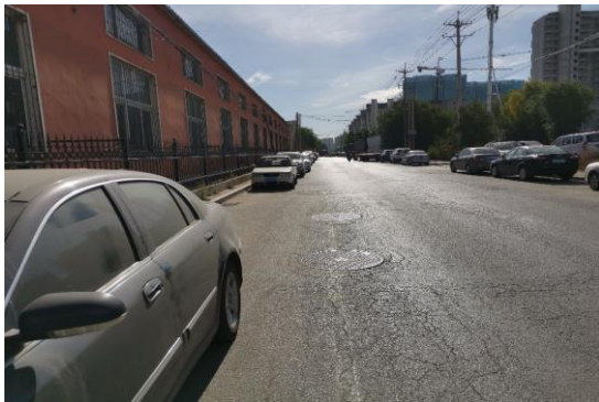
9-2) 220kV 东窑变电站至文官屯牵引站线路工程
