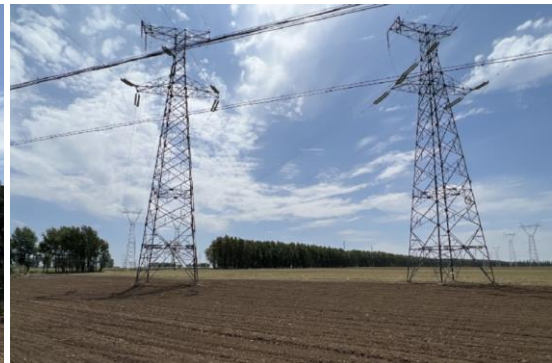
12-3) 220kV 昌北开关站至新昌图牵引站线路工程
