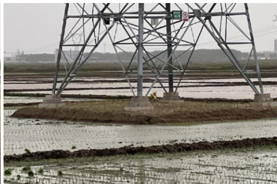
220kV 永业二线 67#恢复
