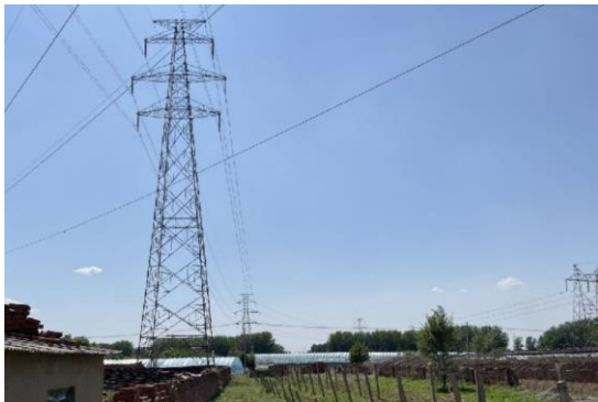
7-7) *220kV 辽阳~迎水寺变第 2 回线路挂线工程*
