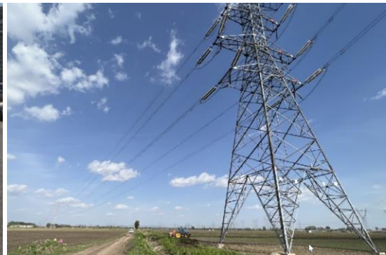
10-2) 220kV 铁蒲 (铁繁) 线 \pi 入新城子开关站线路工程
