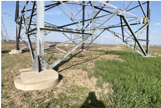
220kV 新蒲一线 1#恢复
