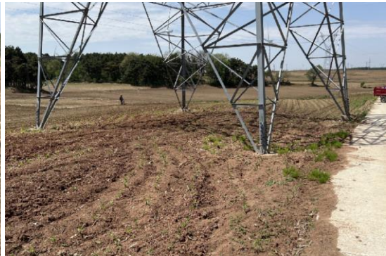
220kV 昌郭线 80#恢复
