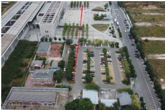
4-5) 220kV 蓝东开关站至新鲛鱼圈牵引站线路工程 (电缆)
