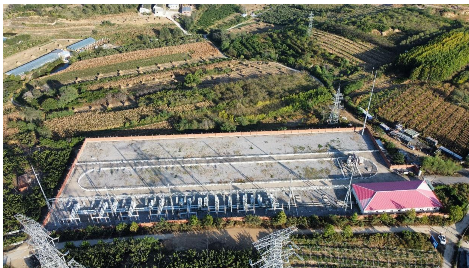
2-1) 新建 220kV 向应开关站工程
