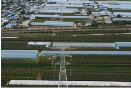
4-3) 220kV 电熊线 \pi 入蓝东开关站线路工程
