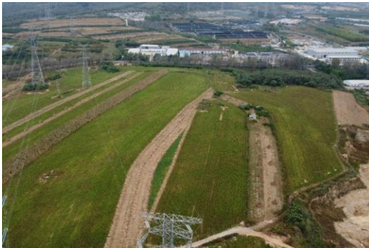
2-2) 220kV 佟宝线 \pi 入向应开关站线路工程
