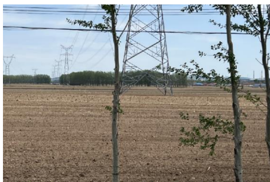
220kV 昌郭线耕地区道路恢复
