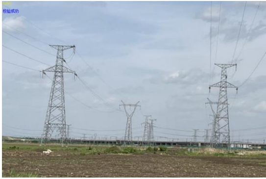
10-3) 220kV 新城子开关站至新台子西牵引站线路工程
