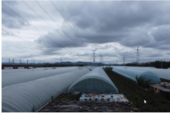
4-4) 220kV 蓝东开关站至仙人岛变电站线路工程
