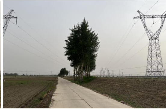
11-4) 220kV 业民变电站至新铁岭牵引站线路工程
