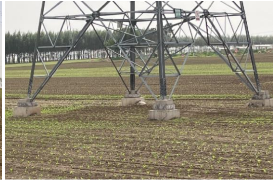
220kV 永业二线 64#恢复
