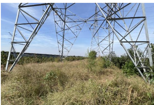
220kV 阎牵甲线 7#恢复
