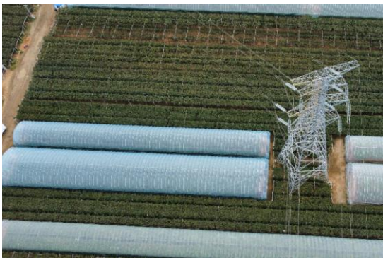
220kV 蓝熊线施工道路恢复
