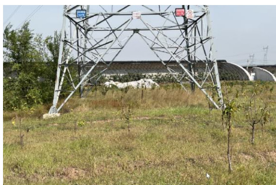
220kV 海阎线 69#恢复
