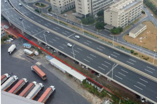
1-2) 220kV 陆港开关站~新大连牵引站线路工程 (电缆)
