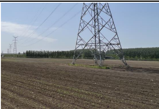
220kV 王牵一线牵张场及耕地区道路恢复
