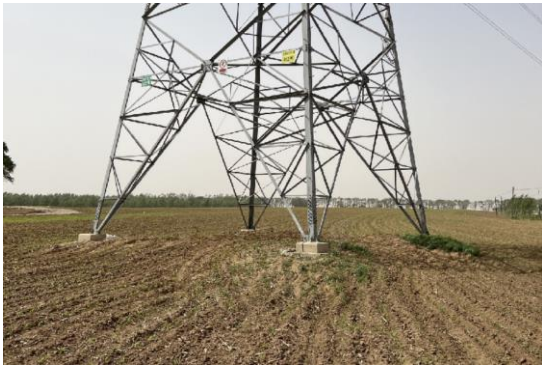
220kV 永业二线 22#恢复
