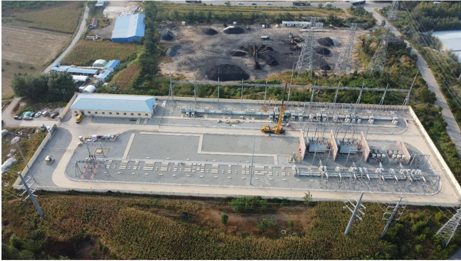
5-1) 新建 220kV 博洛铺开关站工程
