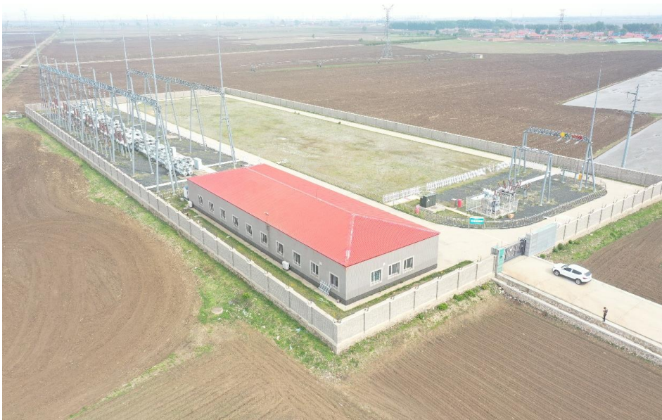
10-1) 新建 220kV 新城子开关站工程
