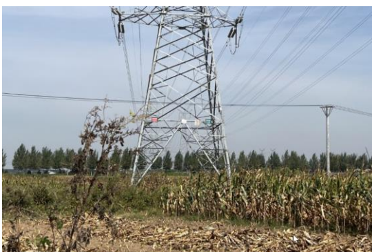
220kV 阎瓦乙线 16#恢复
