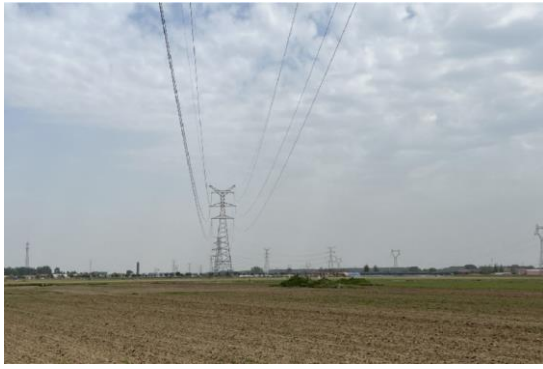
6-2) 220kV 王铁变电站至甘泉铺牵引站线路工程
