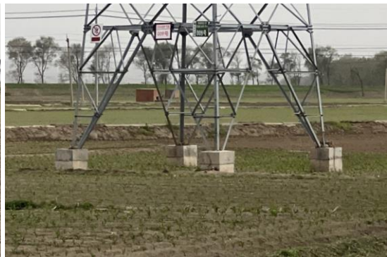
220kV 业牵 1 线 9#恢复
