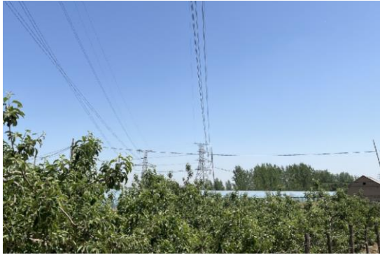
7-5) 220kV 灯首线接入迎水寺变电站线路工程
