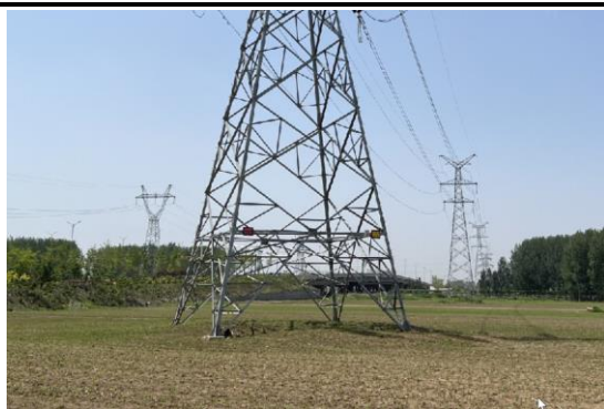
220kV 王牵一线牵张场恢复
