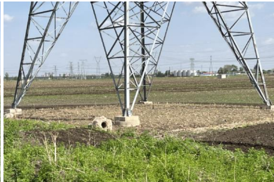
220kV 铁新一线 100#恢复
