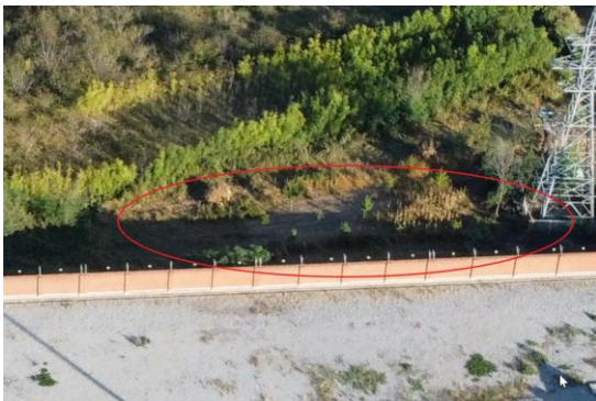
向应开关站站外临建区拆除恢复
