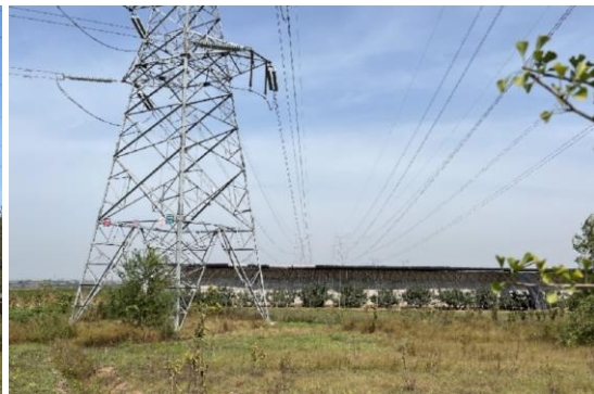
3-2) 220kV 驼瓦线 \pi 入阎店开关站线路工程
