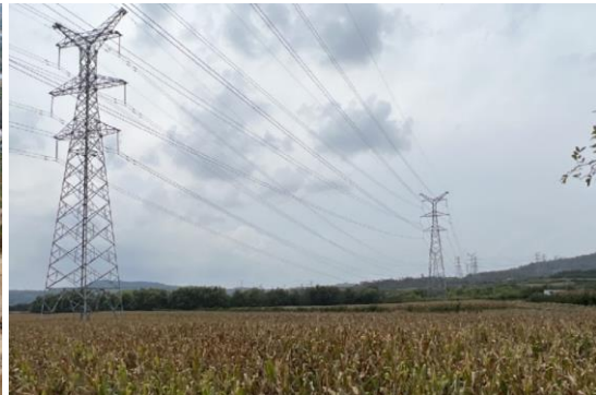
2-3) 220kV 马普线 \pi 入向应开关站线路工程
