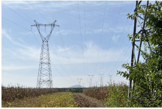
3-4) 220kV 阎店开关站至得利寺西牵引站线路工程
