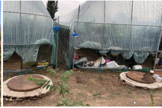
220kV 蓝牵 1、2 线电缆上方恢复
