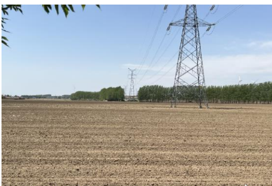
220kV 昌郭线耕地区道路恢复
