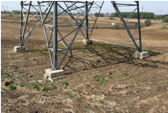
220kV 昌郭线 90#恢复
