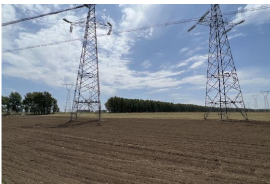
220kV 郭牵 1、2 线耕地区道路恢复
