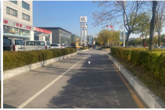
7-4) 220kV 灯首线接入铁西变电站线路工程 (电缆)
