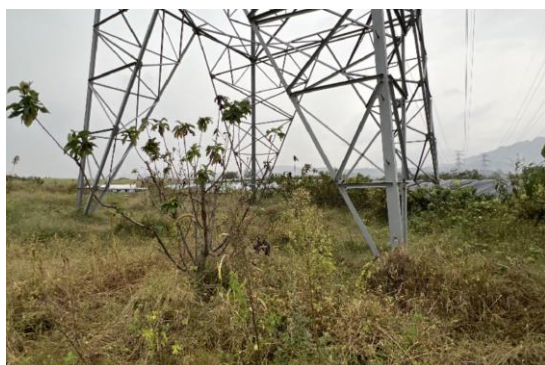
220kV 马宏甲线 72#恢复
