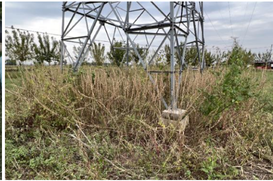
220kV 洛牵线 34#恢复
