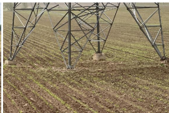
220kV 郭牵 2 线 6#恢复
