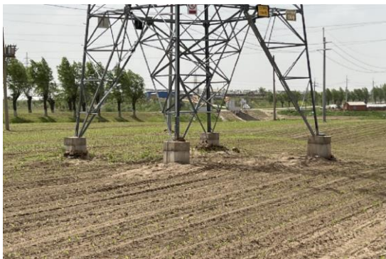
220kV 永业一线 97#恢复
