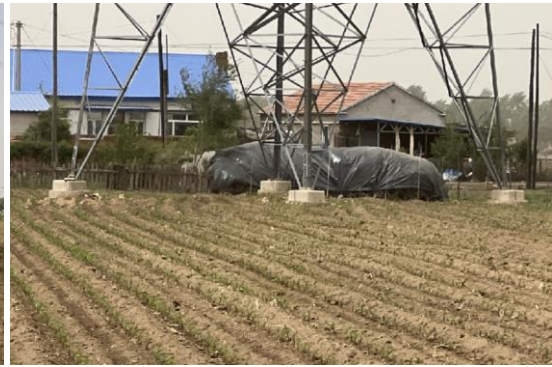
220kV 永业一线 16#恢复
