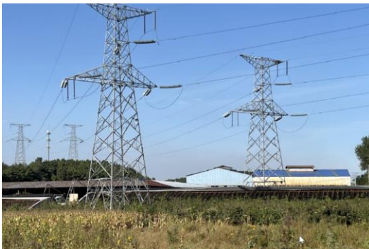
2-4) 220kV 向应开关站至新普兰店牵引站线路工程
