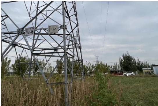
5-4) 220kV 博洛铺开关站至新营口牵引站线路工程
