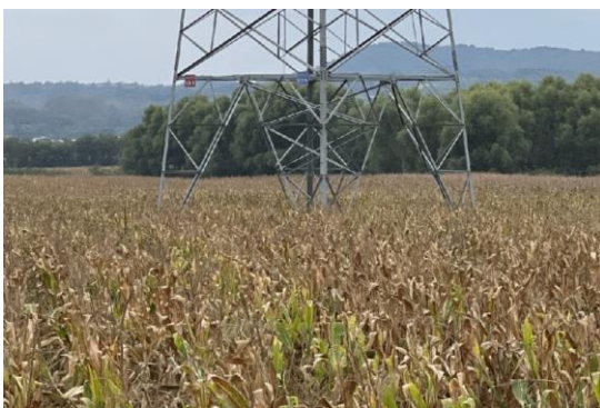
220kV 马宏甲线 78#塔恢复
