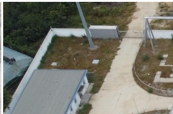
220kV 蓝东开关站地埋式污水处理装置
