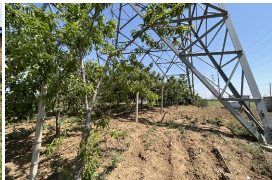
220kV 张迎二线 62#恢复
