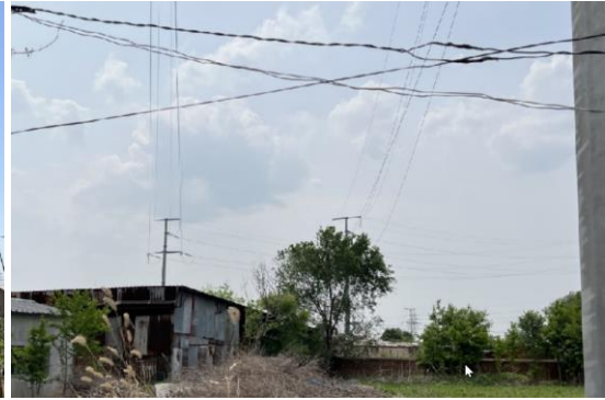
7-6) 220kV 铁首线 \pi 入辽阳牵引站线路工程
