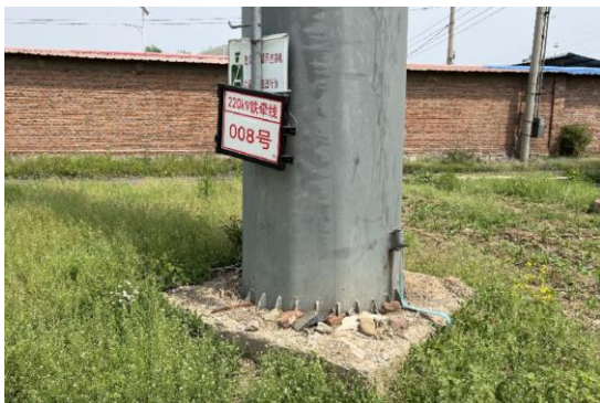
220kV 铁牵线 8#恢复
