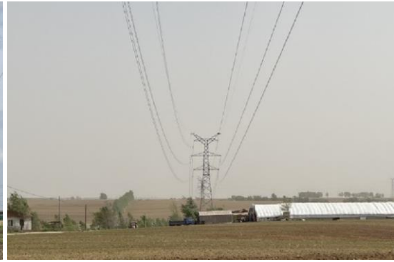
11-3) 220kV 昌北开关站至业民变电站线路工程
