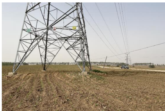
220kV 永业一线牵张场及耕地区道路恢复
