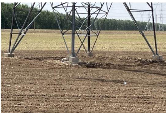
220kV 郭牵 1 线 11#恢复
