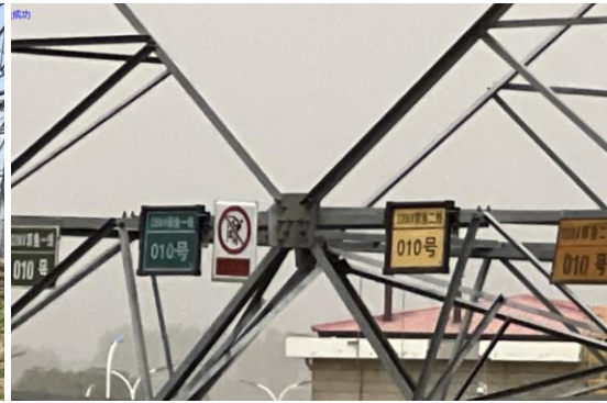
220kV 郭鱼一线塔身警示标识
