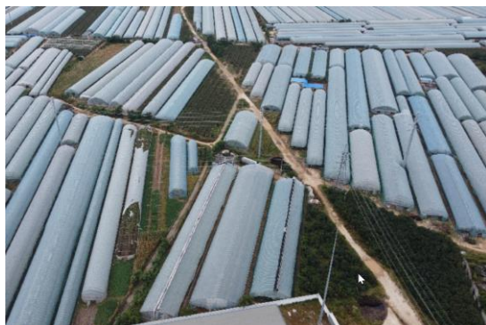
220kV 蓝东开关站周边恢复大棚种植
