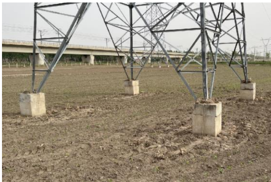
220kV 业牵 2 线 14#恢复
