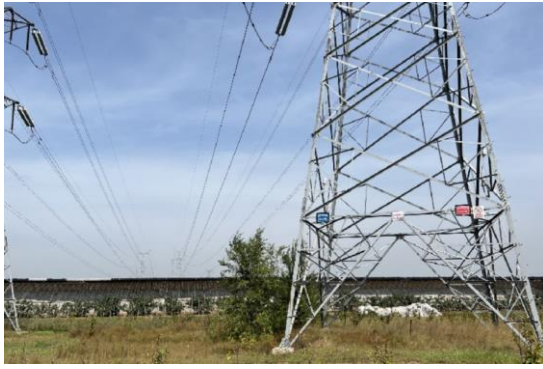
3-3) 220kV 海瓦线 \pi 入阎店开关站线路工程
