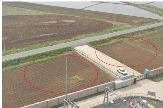
新城子开关站站外临建区拆除恢复
