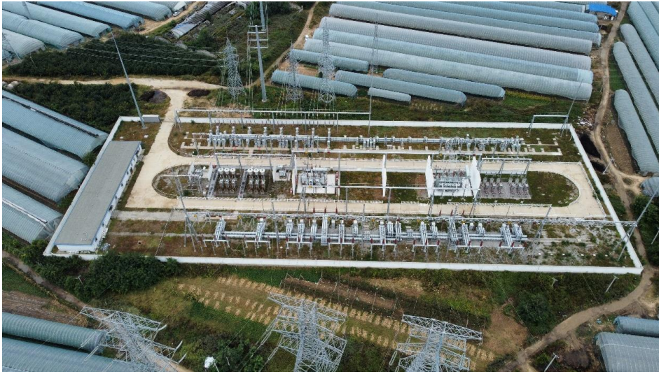
4-1) 新建 220kV 蓝东开关站工程
