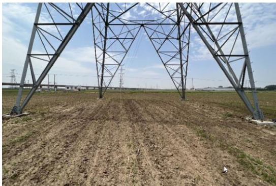
220kV 王牵一线 26#恢复
