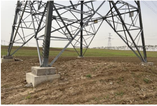
220kV 永业一线 64#恢复
