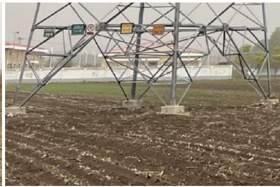
220kV 郭鱼二线 10#恢复
