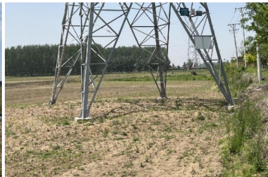
220kV 王牵二线 13#恢复
