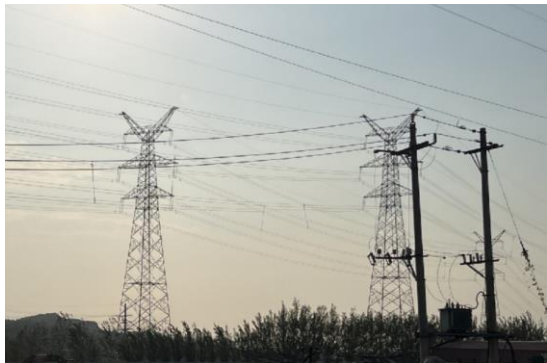
5-3) 220kV 渤镁线 \pi 入博洛铺开关站线路工程
