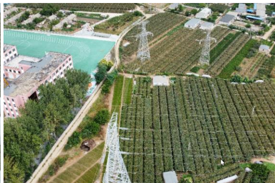
220kV 电蓝线牵张场恢复
