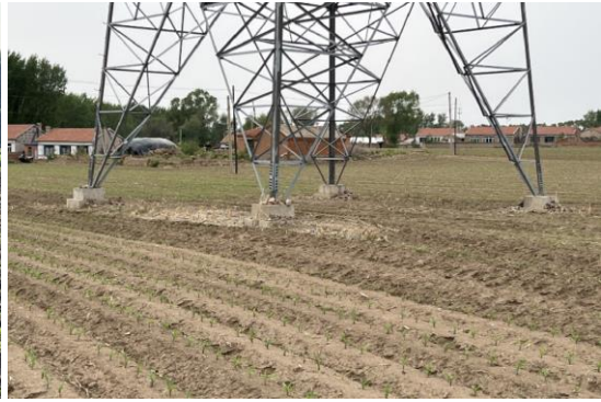
220kV 昌郭线 54#恢复
