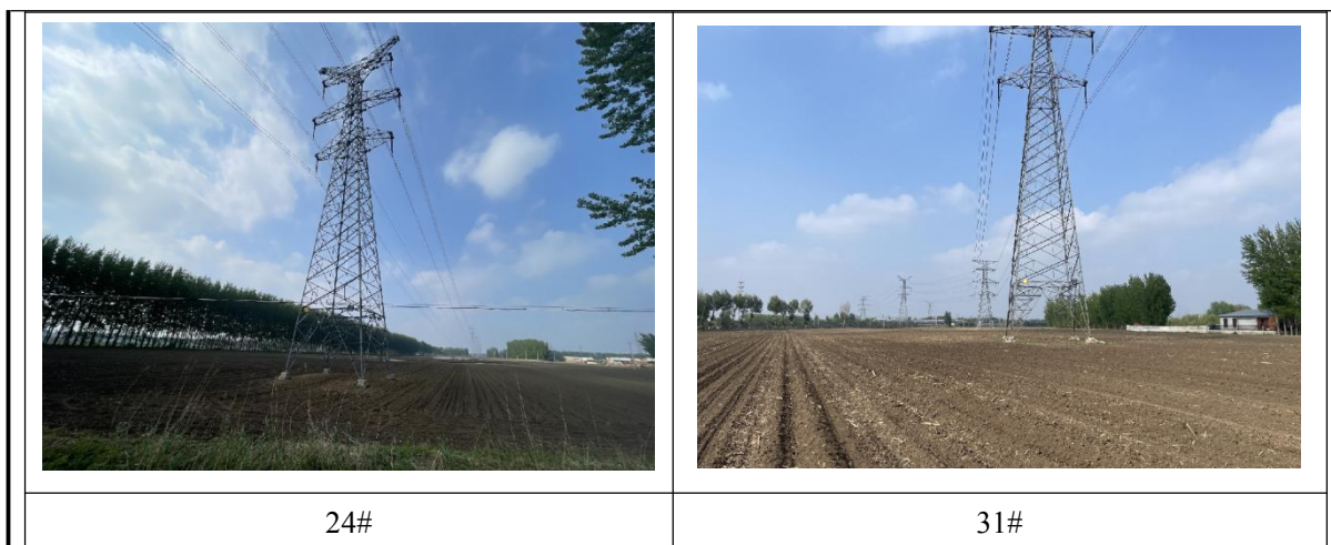
图4-6 本项目现场照片
