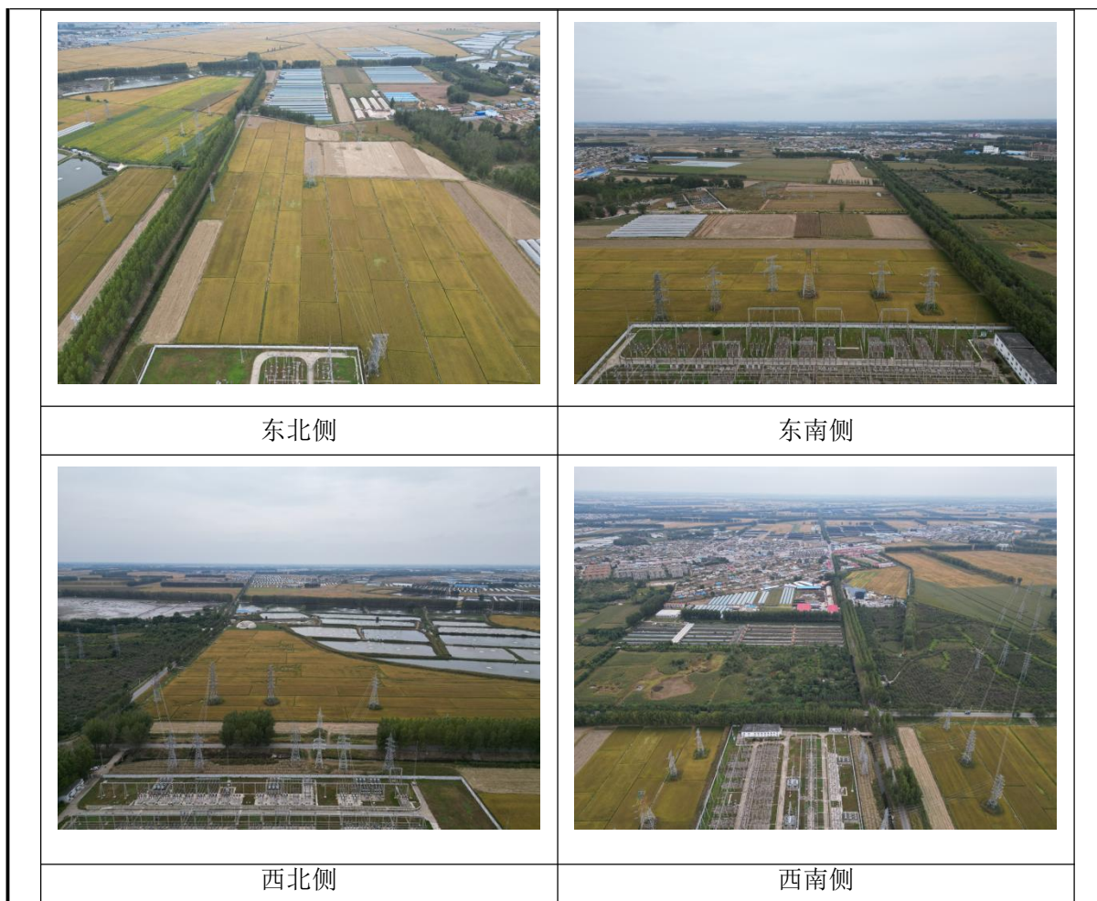
图4-2 本项目现场照片
