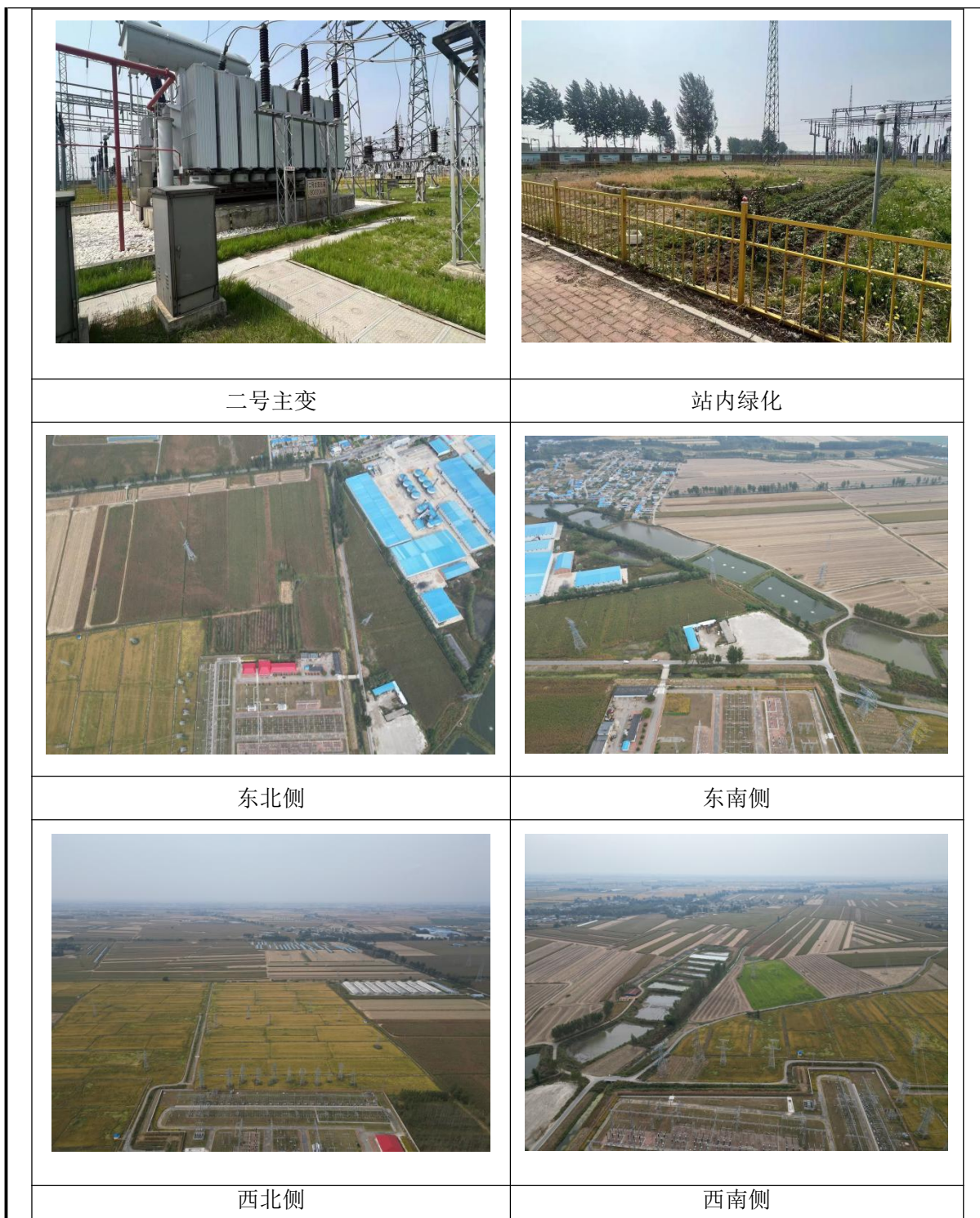
图4-4 本项目现场照片
