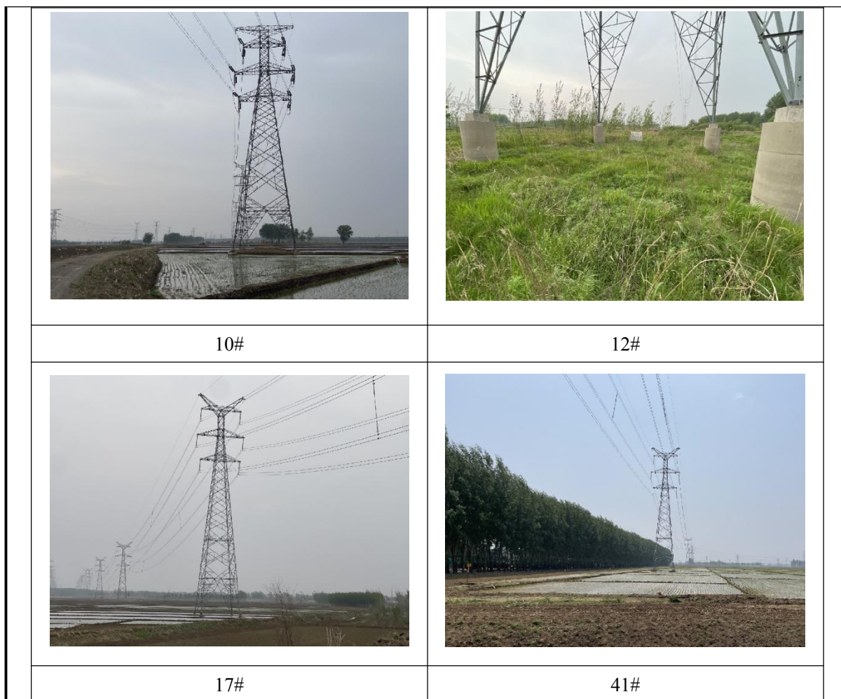
图4-7 本项目现场照片
