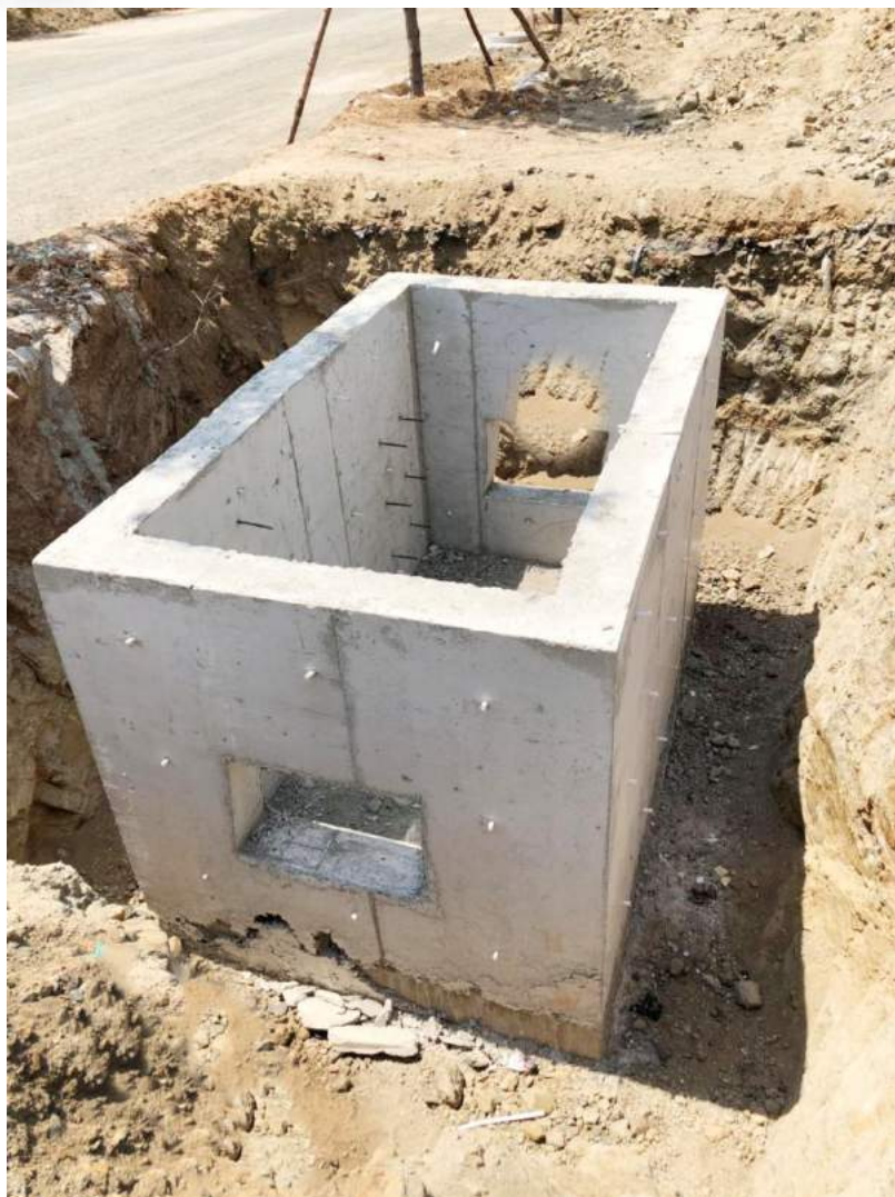
混凝土直线井图
