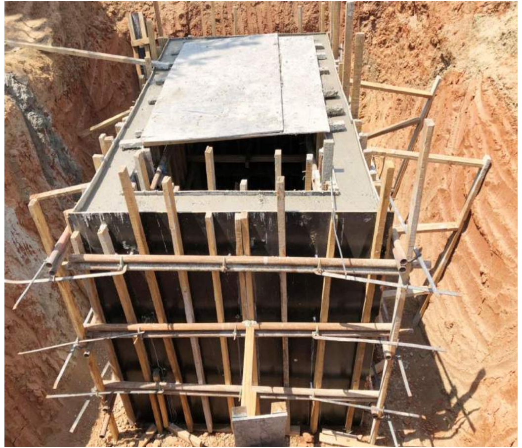
混凝土直线井支模浇筑图
