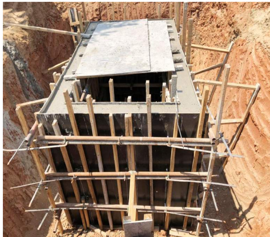
混凝土直线井支模浇筑图
