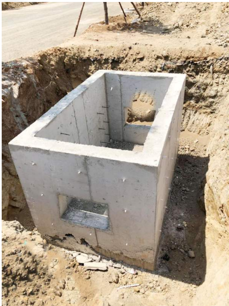
混凝土直线井图
