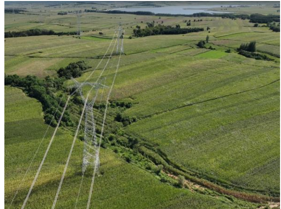
完工后占地恢复
