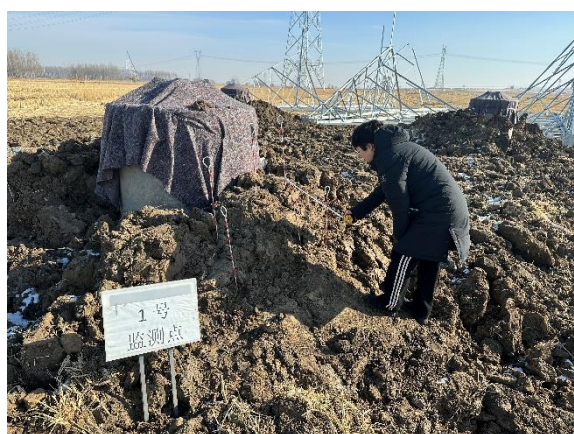
155 号塔基监测点布设
