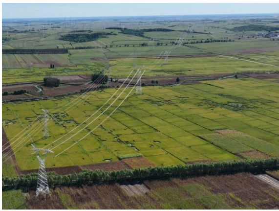
完工后占地恢复
