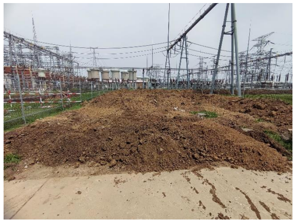
蒲河变临时土方堆放处
