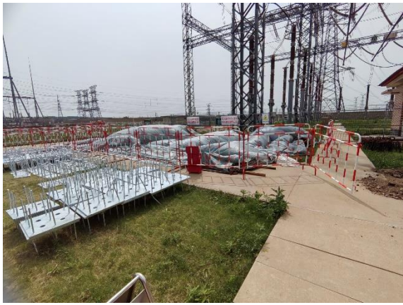
蒲河变电土方临时苫盖
